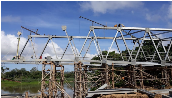
Gambar 11. Pemasangan Rangka Baja Struktur
