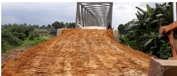
Gambar 15. Penimbunan Oprit Jembatan
