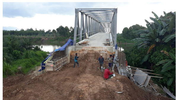
Gambar 14. Dinding Penahan Oprit Jembatan
