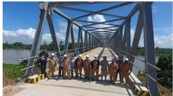
Gambar 17. Jembatan Bena Baru kondisi 100%
