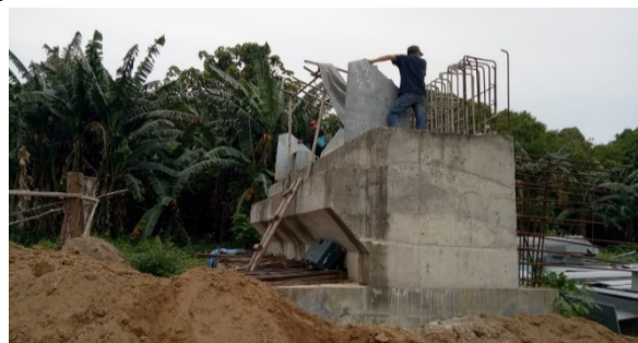
Gambar 9. Pekerjaan Abutmen Jembatan
