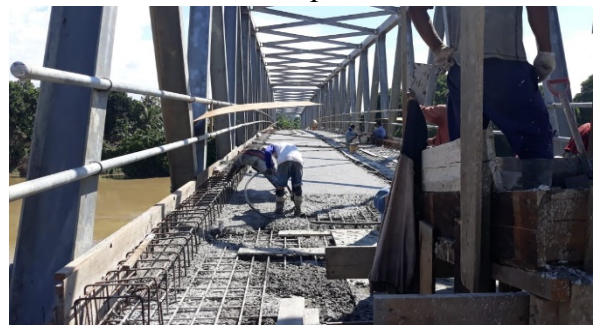
Gambar 13. Pengecoran Lantai Jembatan
