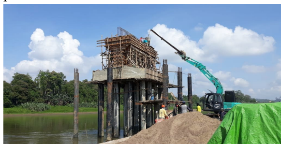
Gambar 10. Pekerjaan Pilar Jembatan
