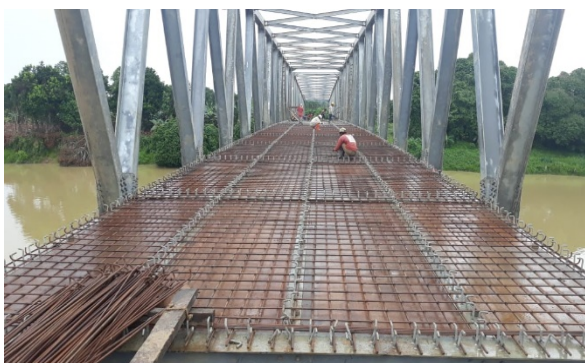
Gambar 12. Bekisting dan Pembesian Lantai
