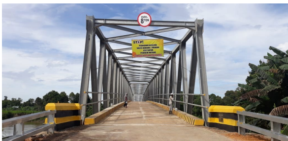
Gambar 16. Pembersihan dan Pengecatan
